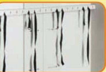
Boce pod pritiskom se mogu osigurati od slučajnog pada pomoću kajševa koji se zatežu.
